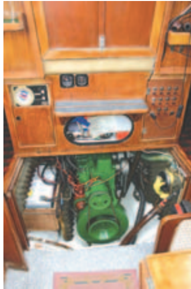
Der nachträglich eingebaute Volvo Penta ist gut zugänglich. Man beachte die Elektrik am Schott
